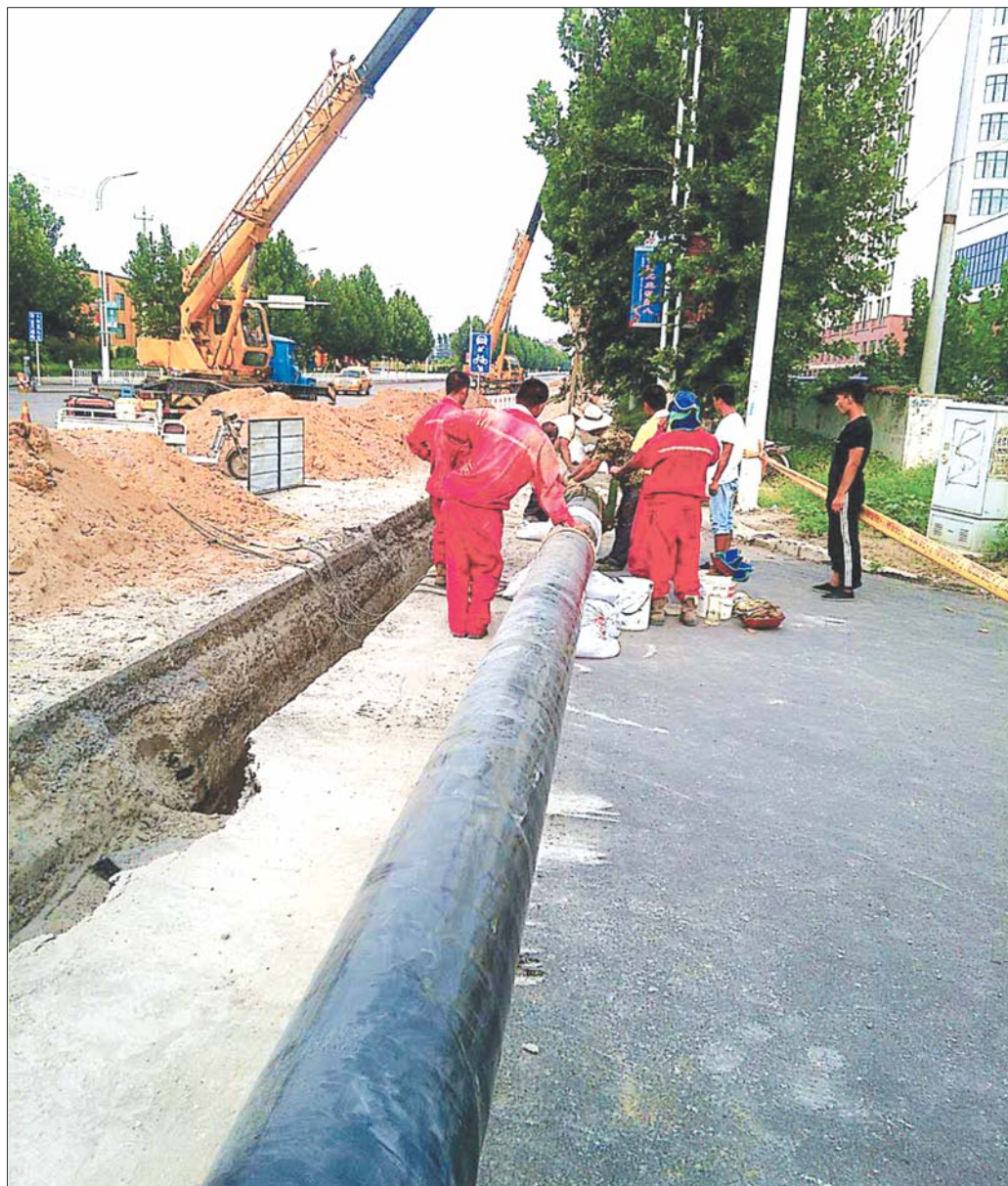
邹城市天然气复线工程正在紧张施工中。
