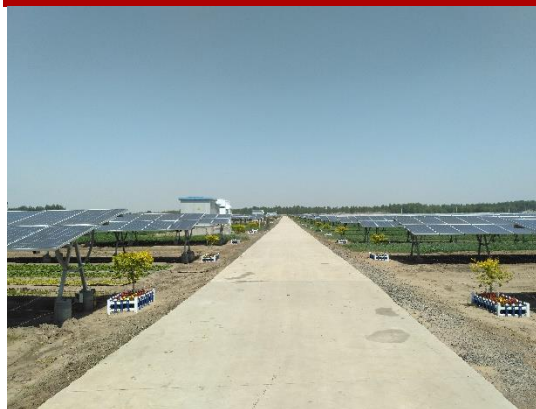
图表 12：辽宁彰武光伏发电站
