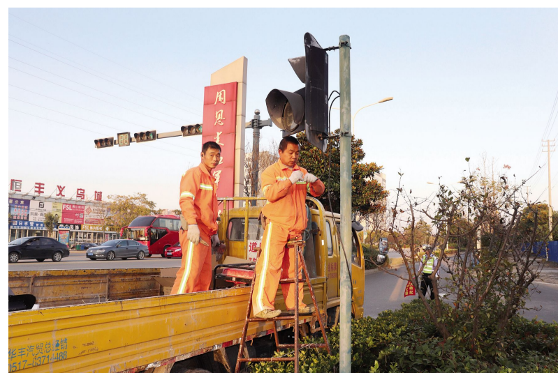
为疏导交通流量、提高道路通行能力,进一步减少交通事故发生,区交管部门在华西路和沈坤路十字路口增设红绿灯,保障市民出行安全。郇玉乔 摄
