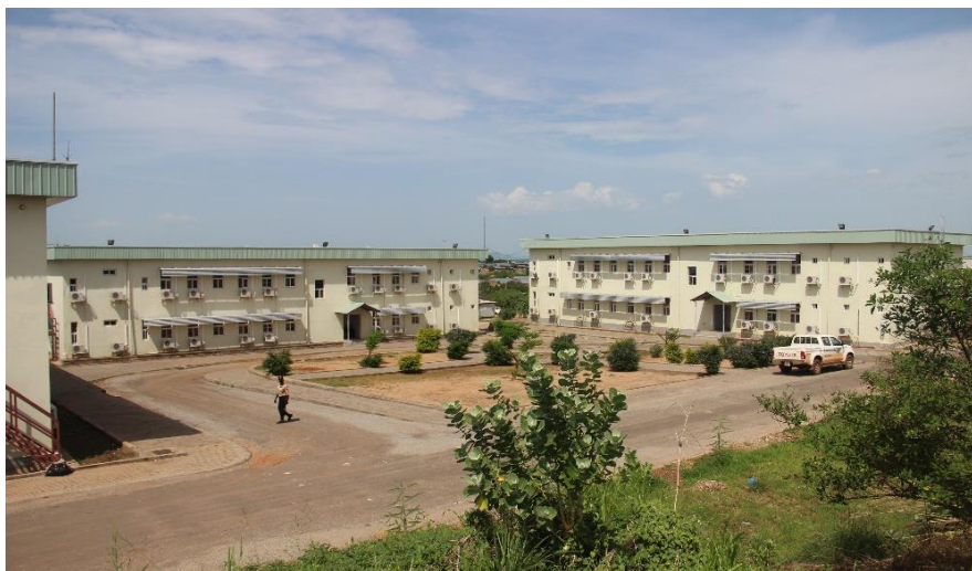
中昊海外建设公司实施的联合国南苏丹特派团总部项目
