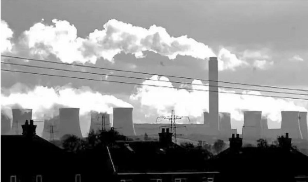
德拉克斯电厂的规模是显而易见的。在容纳锅炉和涡轮机的巨大建筑两侧，矗立着6座冷却塔。白色的蒸汽飘向天空。在厂房的中央矗立着一个高达259米的烟囱。
