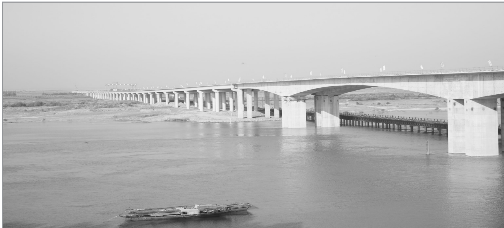
嫩江大桥重点项目有序推进。
