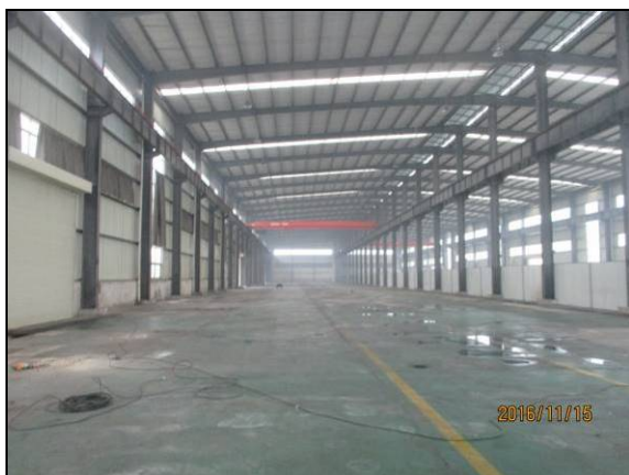
项目拟建地（新煌集团 3#厂房南跨）
