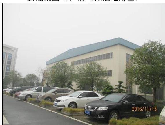
新煌集团 5#厂房（拟建地南面）
