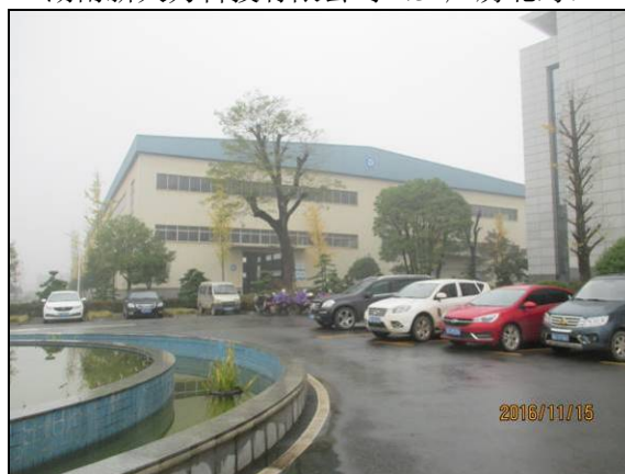
新煌集团 4#厂房（拟建地南面）
