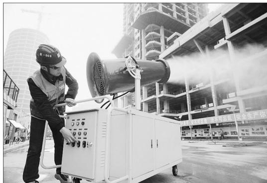
在成都高新区一标准化建筑工地,工作人员正在操作集成式环境监测与喷淋联动系统。系统根据环境空气质量变化,监测工地PM<sub>10</sub>、PM<sub>2.5</sub>、温度等指标,一旦超过限值,自动喷淋水雾降尘。目前,监测系统一期工程已在中心城区的120个建筑工地全面推行。
