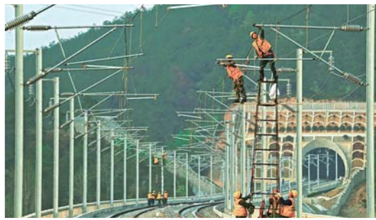
杭黄高铁施工进入冲刺阶段
