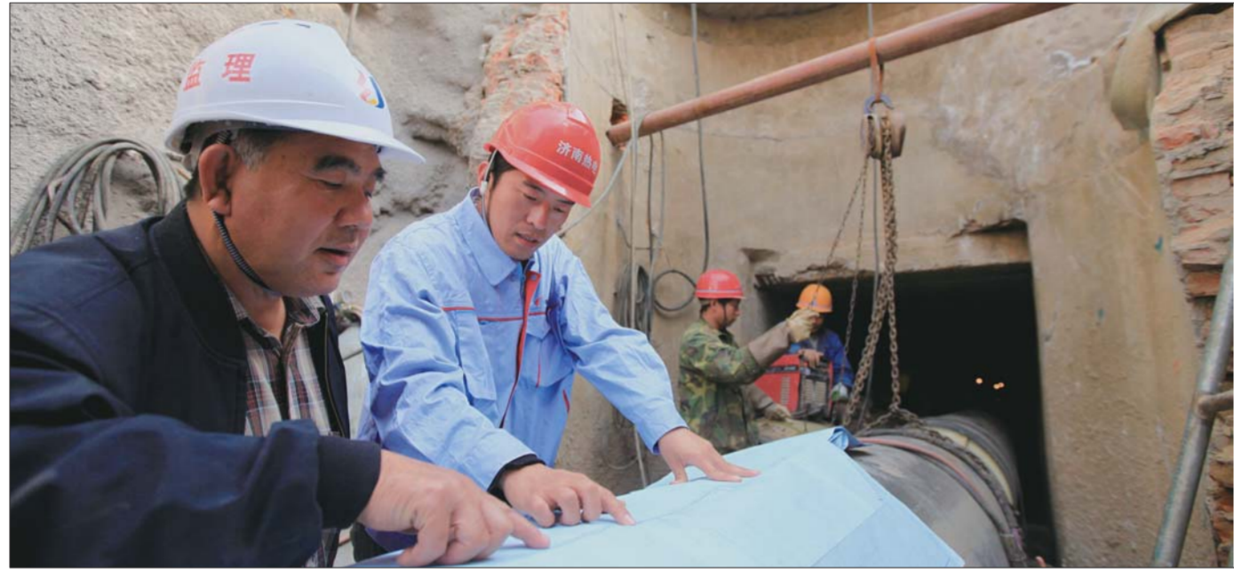
济南热电工作人员对纬二路供热管网进行改造，通过管网改造等手段省出来部分热量用以提升居民室内温度。
