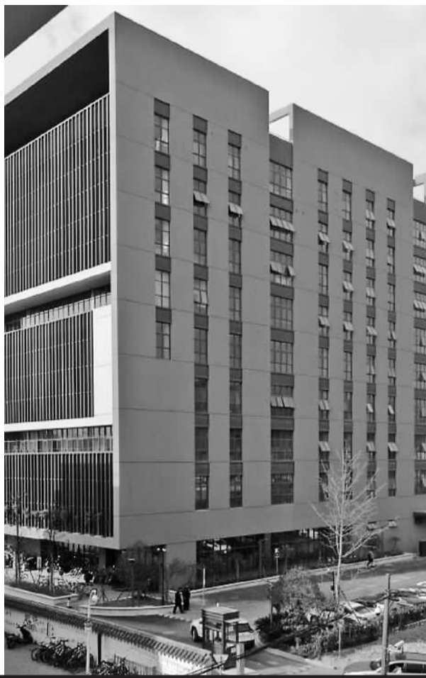
宁波大学科技服务大楼。
