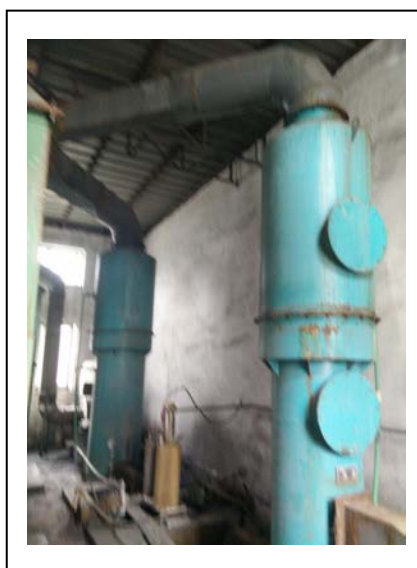
燃煤锅炉脱硫除尘器现状
