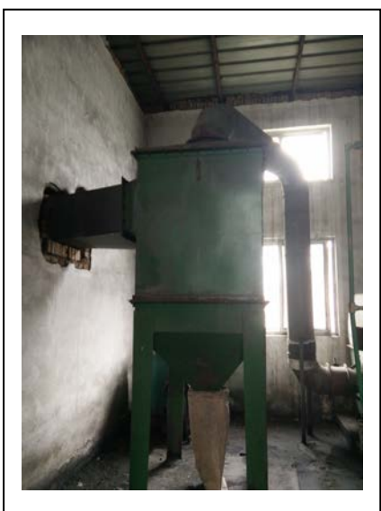
燃煤锅炉脱硫除尘器现状
