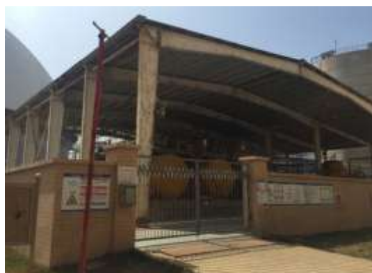
图 4-11 氨站外围堰
