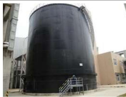
图 4-16 脱硫系统事故浆液罐
