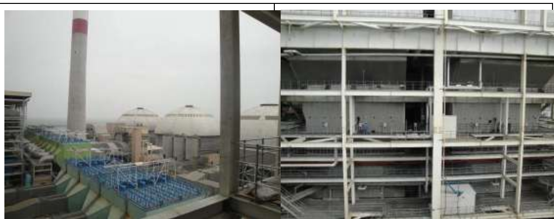
图 4-3 静电除尘器
