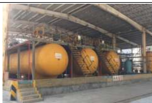
图 4-10 储氨区围堰
