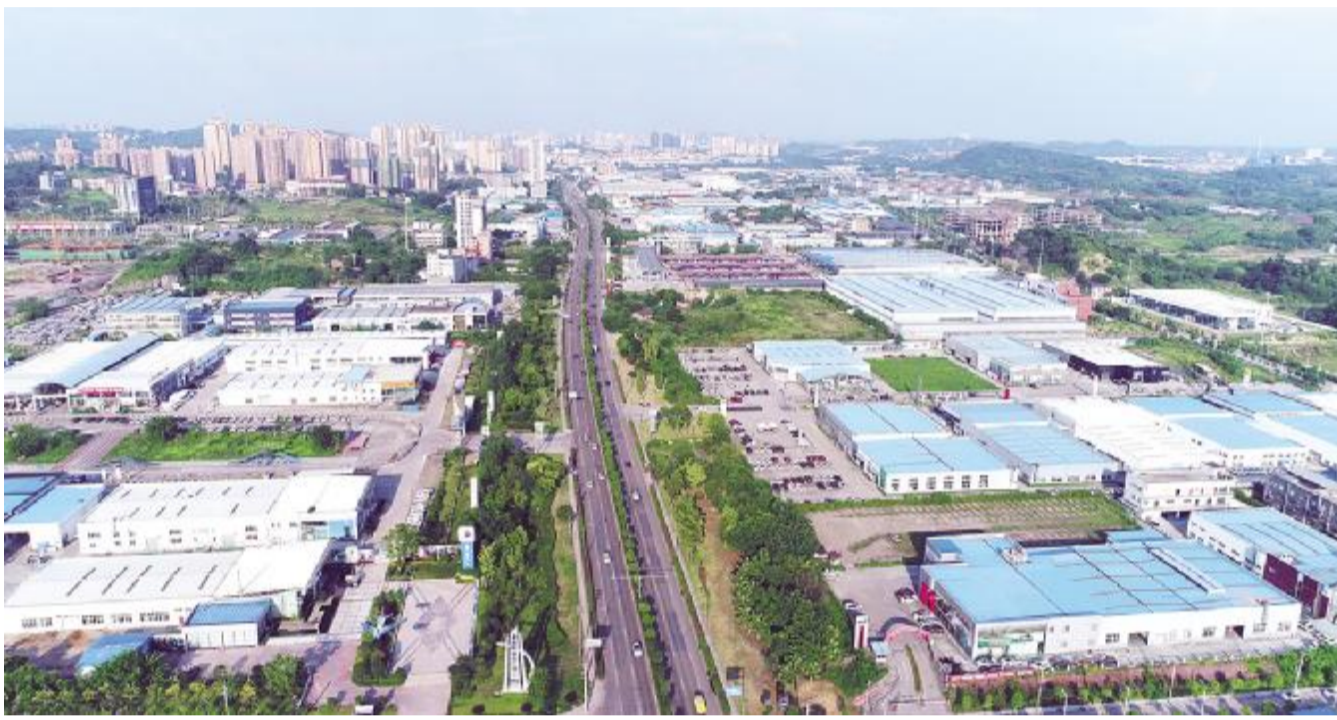
贡井工业园区
