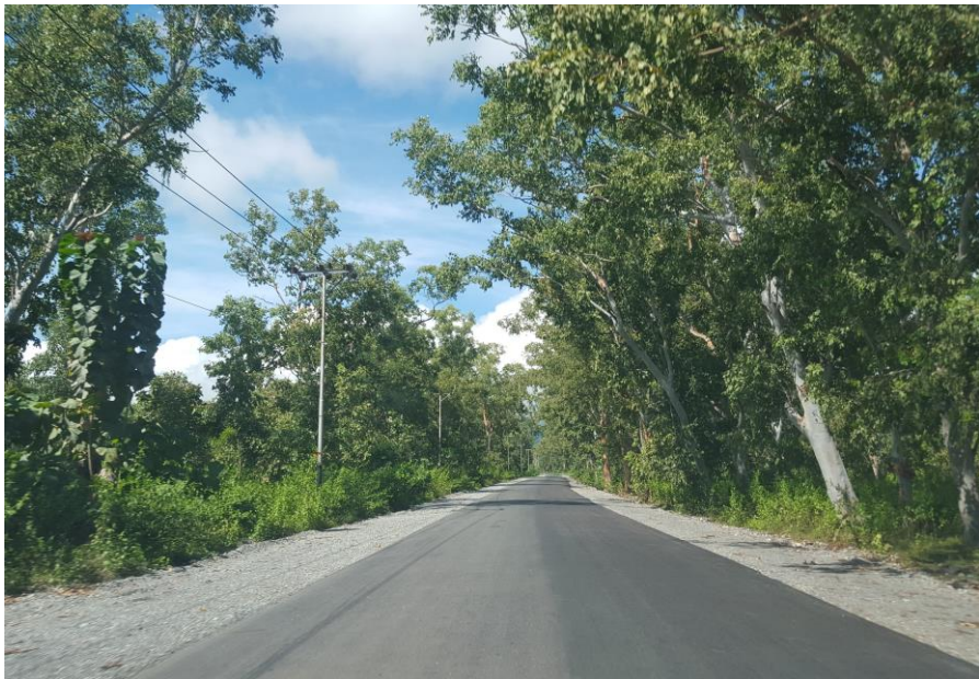
马纳图托-拉克鲁巴道路改造及维护项目
