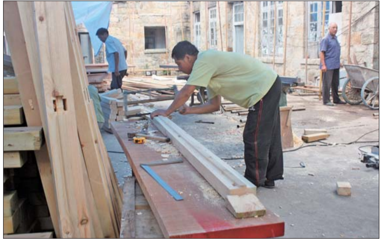
▲修复威海卫学校旧址工程中,所有的木框和门框均是纯手工制作。 记者 王帅 摄
