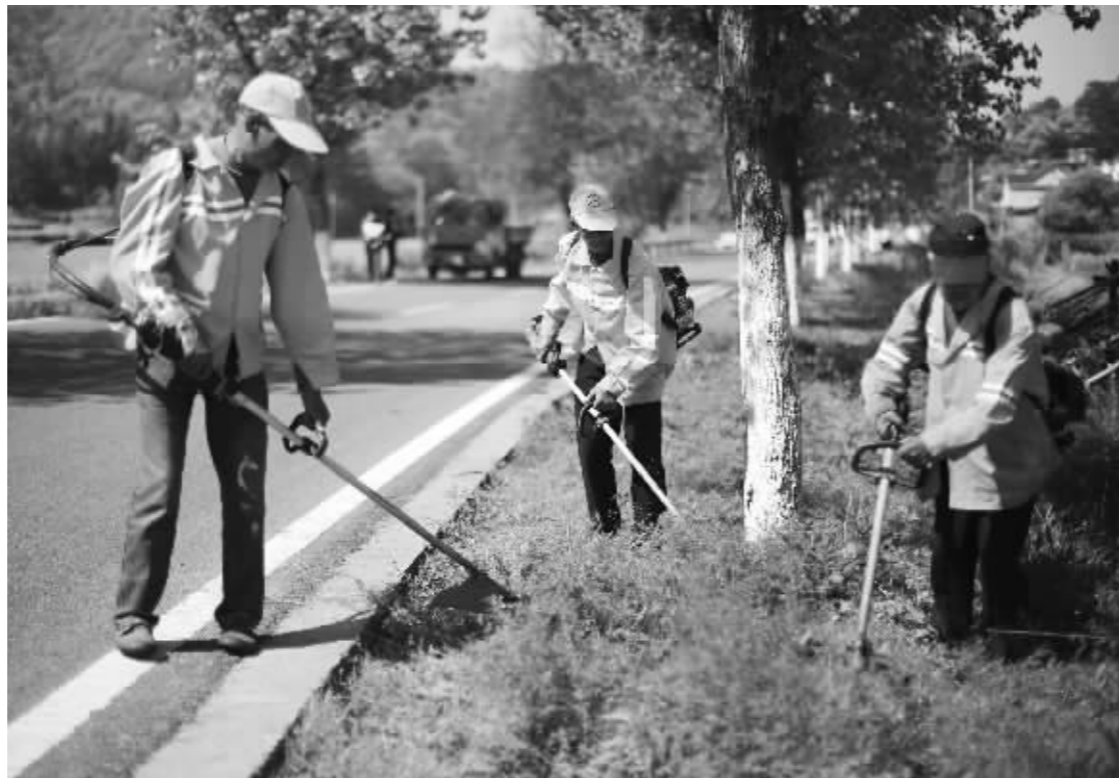
近期以来,随着气温升高,公路两边的杂草丛生,横峰公路分局组织养护作业人员对S205省道和S514省道的公路路肩杂草进行集中割除。目前,青板道班和葛源道班养护职工完成机械除草30多公里,积极创建“畅、安、舒、美”的公路环境。图为该局葛源道班职工在S514省道进行机械除草。尹成军 摄
