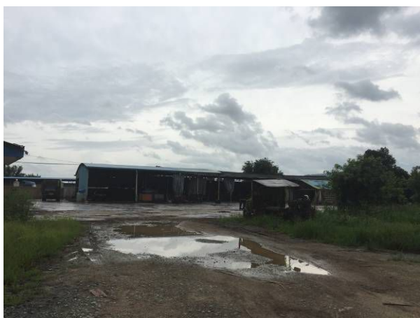
项目西面厂房
