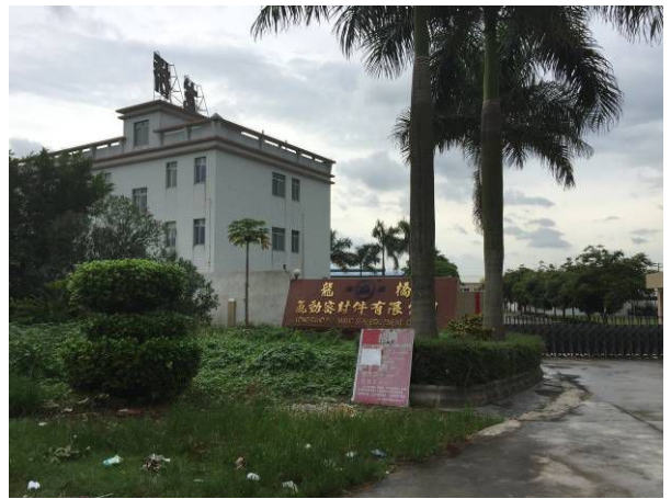
项目东北面开平市龙桥气动密封件有限公司
