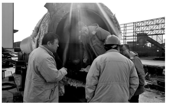
近日,在4#加氢高压换热器备机检修完成后,东鑫垣公司机修金属镁分厂机加车间迅速把精力投入到1#加氢高压换热器的备机抢修中,这项工作是他们春节期间重点工作之一。 马佳亮 摄
