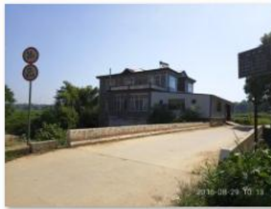
东南角生产办公楼
