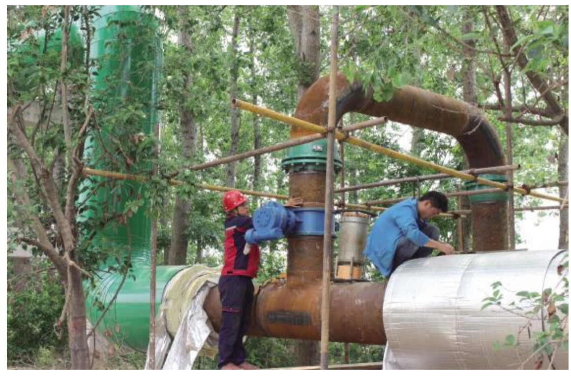
今年以来,坐落在黄沙港镇包装产业园内的江苏勤力热电公司大力实施技改升级,新上二期工程,计划投资1.5亿元,扩建130吨锅炉和15兆瓦发电机组,新建10公里热电网管。图为工人正在抓紧安装输气管道。
