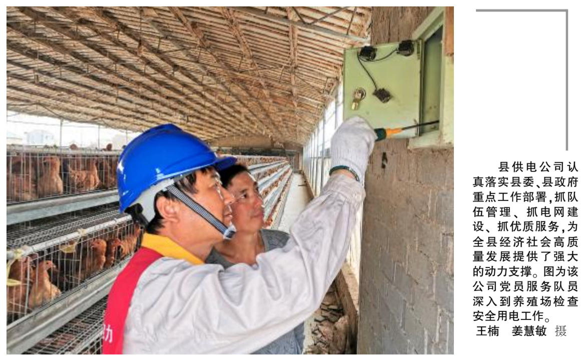
县供电公司认真落实县委、县政府重点工作部署,抓队伍管理、抓电网建设、抓优质服务,为全县经济社会发展提供高质量的动力支撑。图为该公司党员服务队深入养殖场检查安全用电工作。
