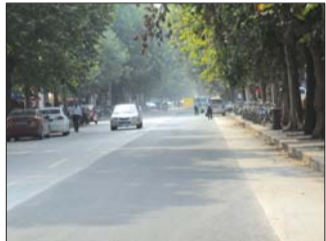
文化路路段道路铺设基本完成。 本报记者 赵苏炜 摄
