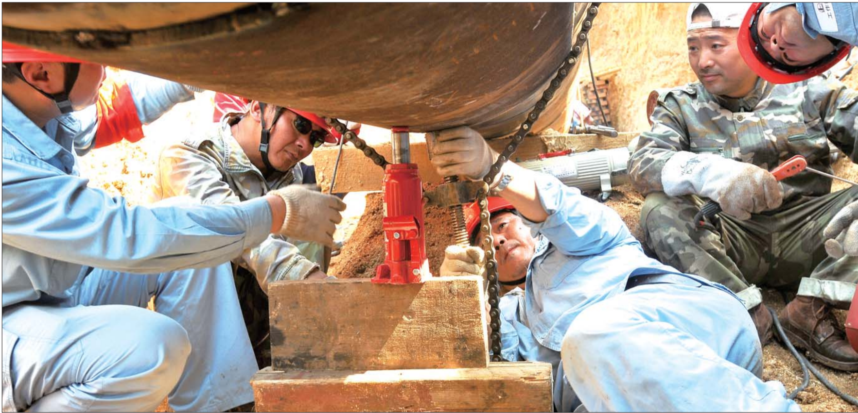
抢修管道腐蚀点。
