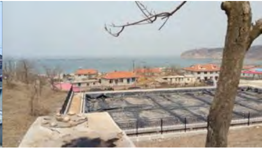
北侧养殖库房
