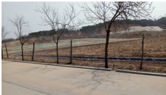
垃圾填埋场填埋区
