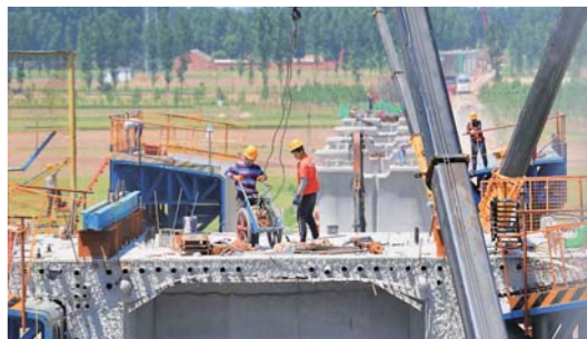
京唐城际铁路建设稳步推进
