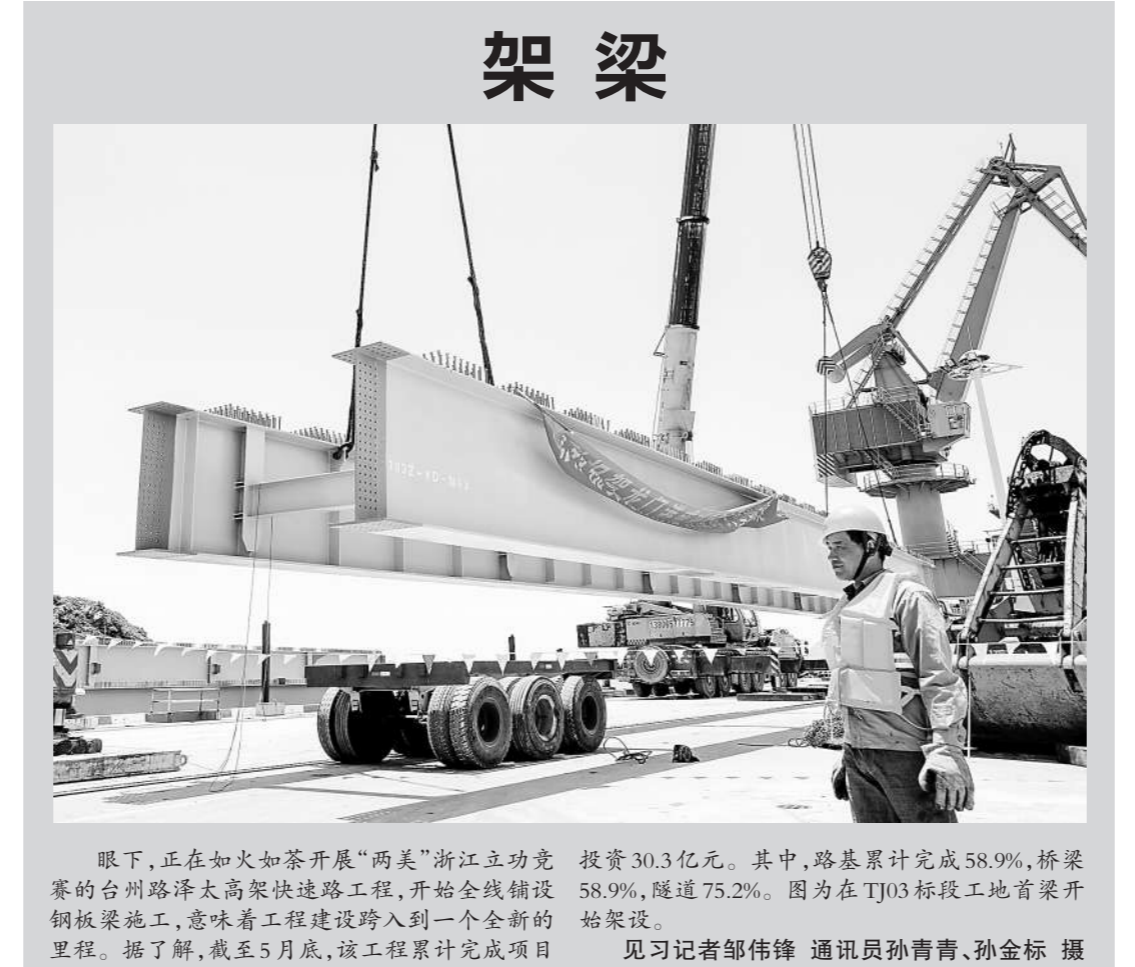
眼下,正在如火如荼开展“两美”浙江立功竞赛的台州路泽大高架快速路工程,开始全线铺设钢板架施工,意味着工程建设跨入到一个全新的里程。据了解,截至5月底,该工程累计完成项目
