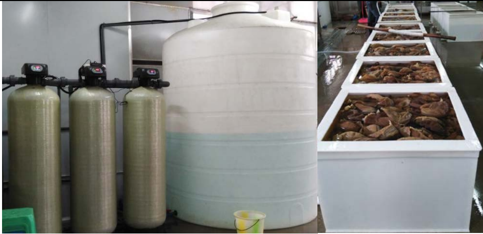
图 5-4 纯水净化装置与可移动浸泡池
