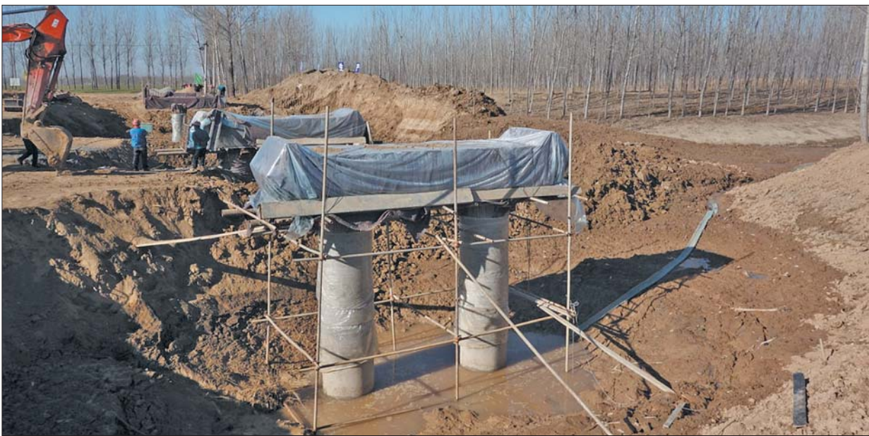
小杨沟生产桥施工现场。 本报见习记者 王杰 摄
