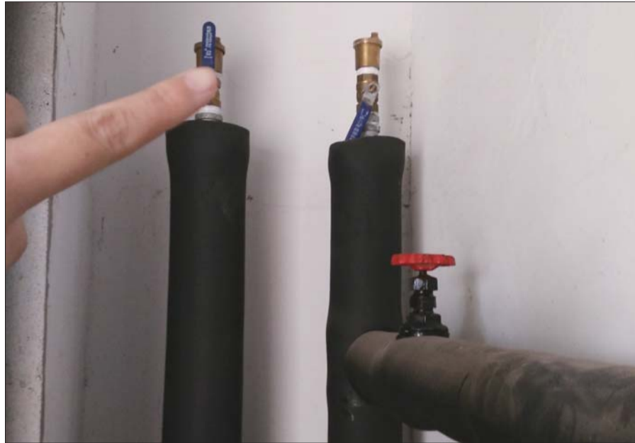
▶各个单元又新安装排气阀。本报记者 梁越 摄
