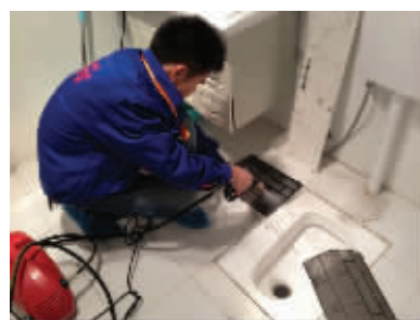
高压水枪清洗过滤网与外壳
