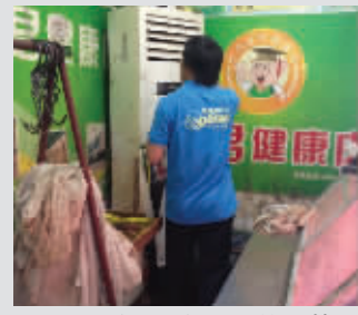
96258的空调维修师傅为麓山润城居民检查空调设备。
