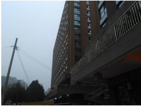
所在项目楼外观
