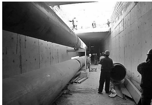
施工人员正在进行旅游北路综合管线廊建设。(记者 沈玉杰 摄)
