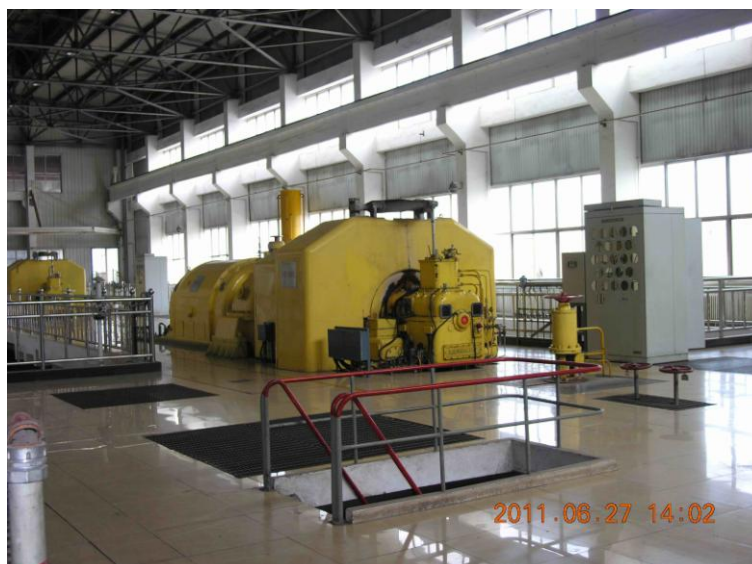
发电机隔声罩
