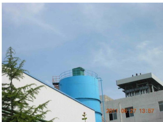
石灰石粉库顶部布袋除尘器
