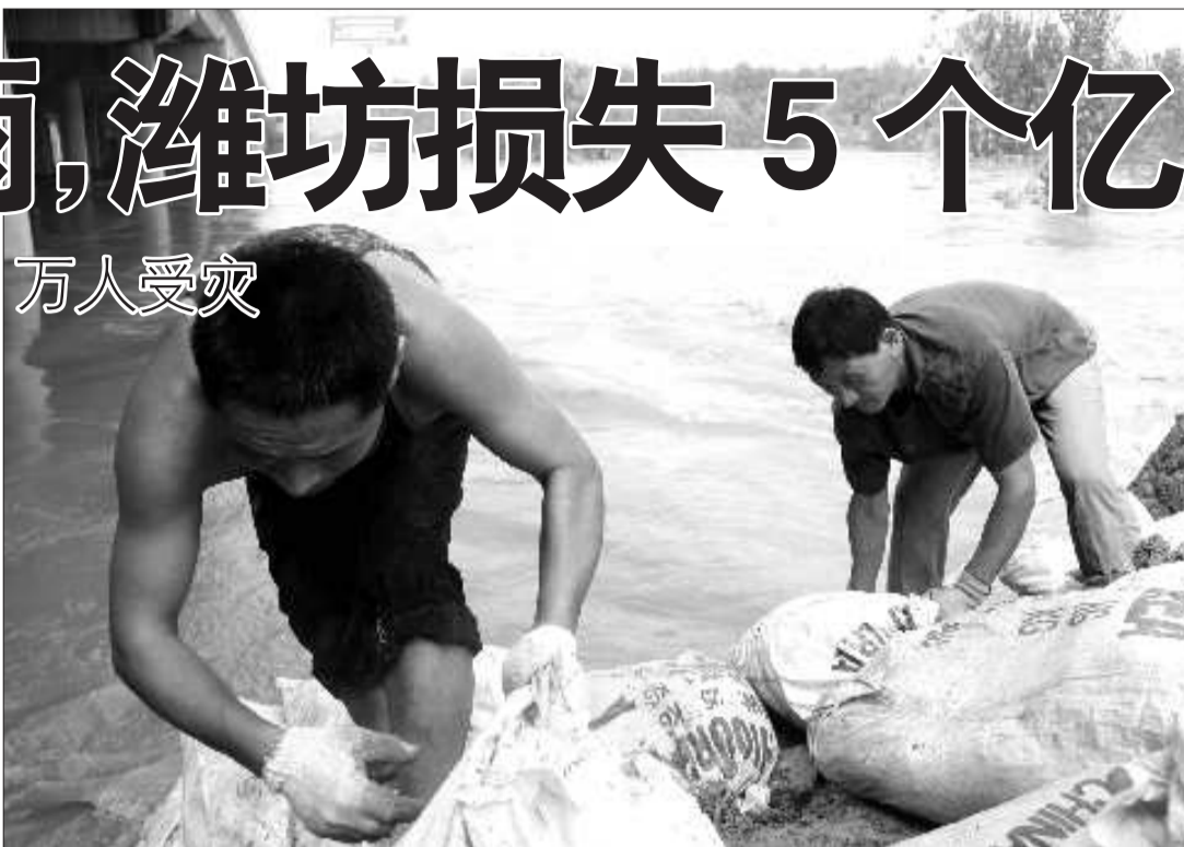
16日,在青州弥河大桥桥洞,为防止泄洪决堤,工人加紧在岸边增培沙土袋。 本报记者 吴凡摄
