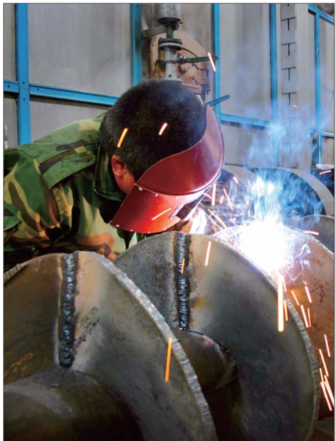
▲工作人员正在维修供暖设备。
