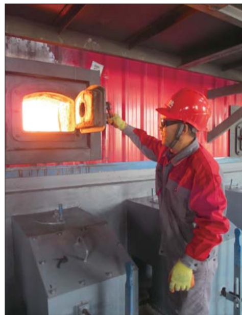
▲工作人员检查锅炉情况。
