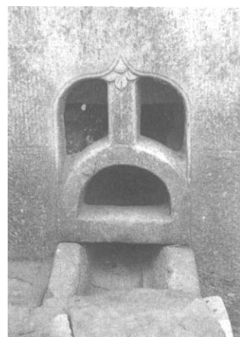
图 4：龕形排水石槽
