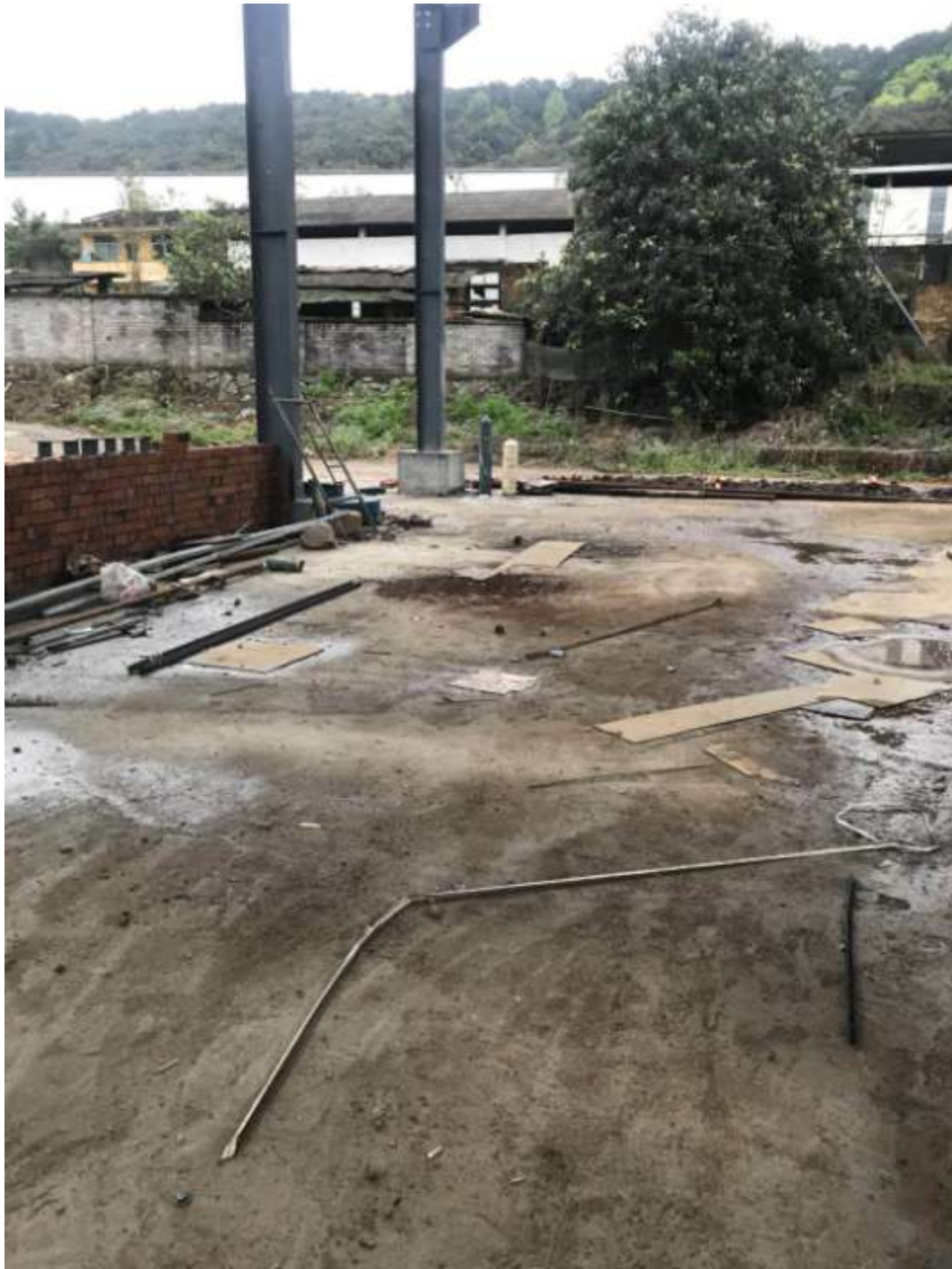
图 3.3-1 锅炉房现状照片
