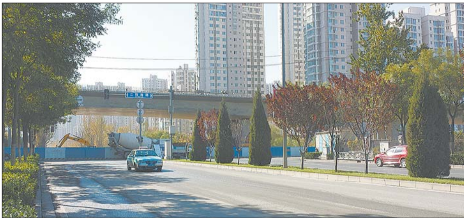
领秀城北门处高架桥施工进度顺利。
