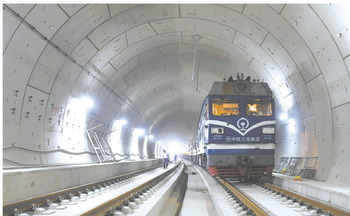
6月12日，完成铺轨后的京张高铁清华园隧道。
