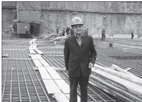
陈丽生学长在央视新址施工工地
