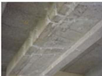
混凝土梁、板裂缝注胶修补
