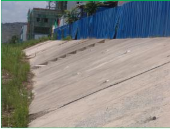
混凝土护坡
