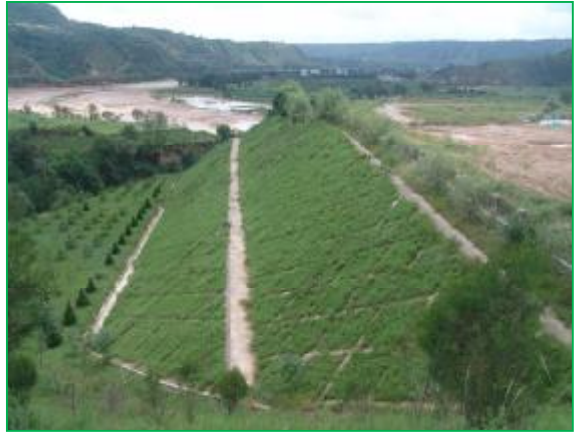
浆砌石网格植物护坡护坡
