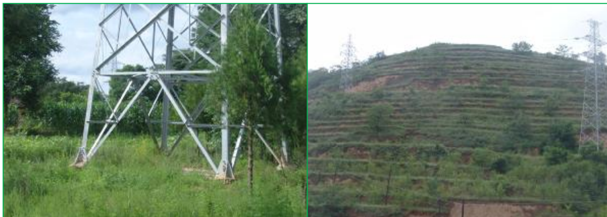
场外输电线路场地整治恢复
