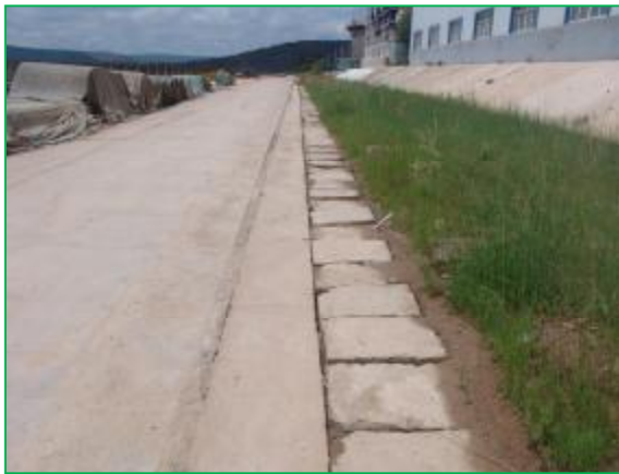
混凝土盖板排水沟
