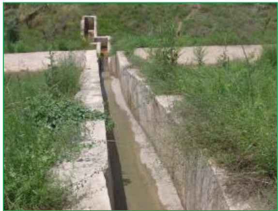
混凝土急流槽
