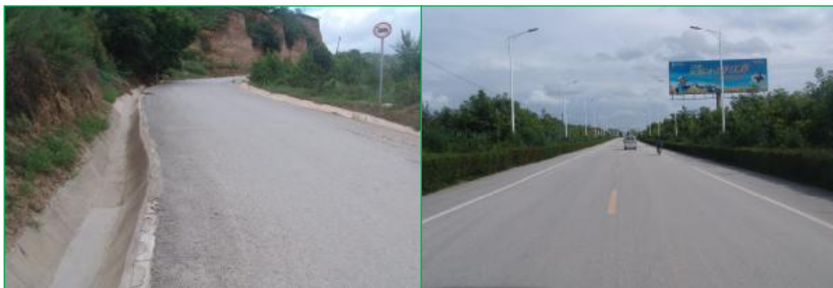
场外道路排水沟
