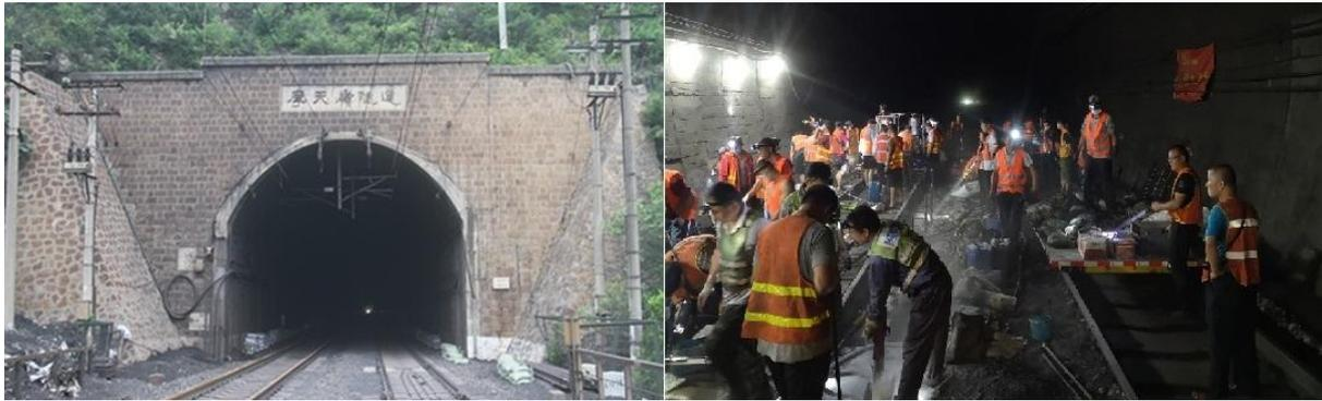
2018年7月16日至7月22日，公司茶坞工务段管内经历了入汛以来最强降雨，地处燕山腹地，全长2495米的大秦线摩天岭隧道周边区域降雨量更是远超去年同期。7月27日11时左右，巡线职工发现摩天岭隧道轨枕板线路道心有积水，在动态观察中又进一步发现轨枕板下冒水量持续加大，翻浆冒泥处不断增多，轨枕板空吊数量增加，且过车后有两块轨枕板折断，严重危及行车安全。面对突发水害，公司干部职工立即行动起来，克服重重困难，在5个天窗点内顺利完成了整治任务，共计增设隧道基底泄水孔14个，清理换填排水沟与轨枕板间泥浆石砟40米，“锚注一体化”加固基底20米，隧道水沟清淤400米，从根本上缓解了隧道涌水对线路状态的影响，提高了轨道线路的稳定性，打赢了这场隧道水害整治攻坚战。
