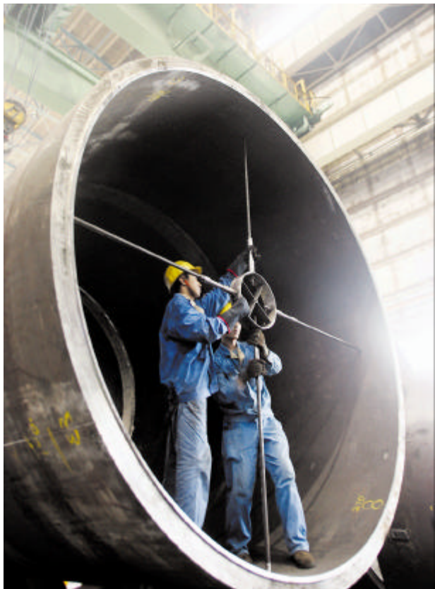
国内首台35万千瓦超临界锅炉整体水压试验成功
