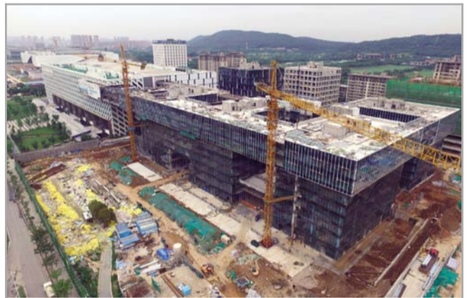
▲近日,三公司全球公共采购交易服务总部基地办公一期封顶。项目位于武汉市光谷,总建筑面积11.11万平方米,由5栋办公楼组成。 冯兴庚 金虎/摄
