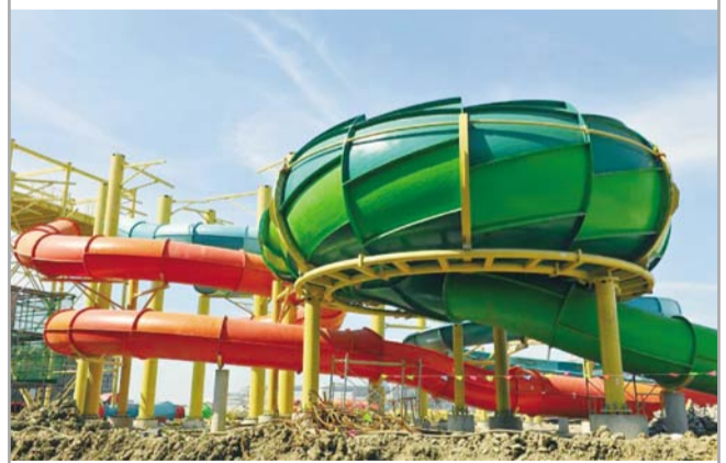
▲近日,上海分公司浙江山水六旗工程游乐设施安装完成。项目总用地面积808.7亩,由陆乐园和水乐园两部分组成,规划设置6大主题分区约60项游乐设施。 吴正路/摄
