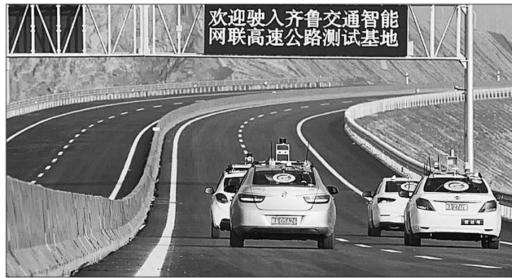
齐鲁交通智能网联高速公路测试基地。
