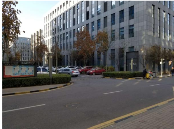
项目西侧 10 号楼
