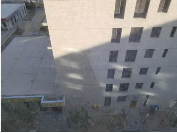
项目东侧 2 号楼
