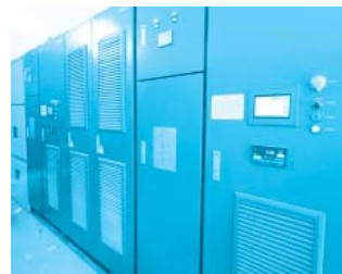
图7 高压变频器现场安装情况
