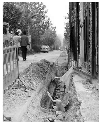
洪家楼小区正在进行管道燃气施工。今年年底前有望通上天然气。(记者 丁捷 摄)
