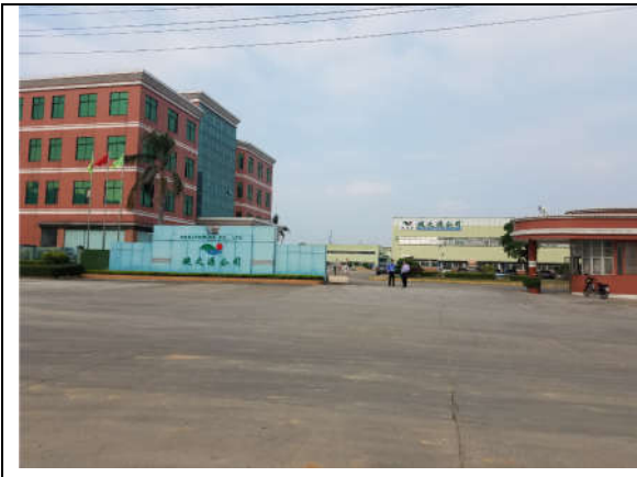
项目现状照片
